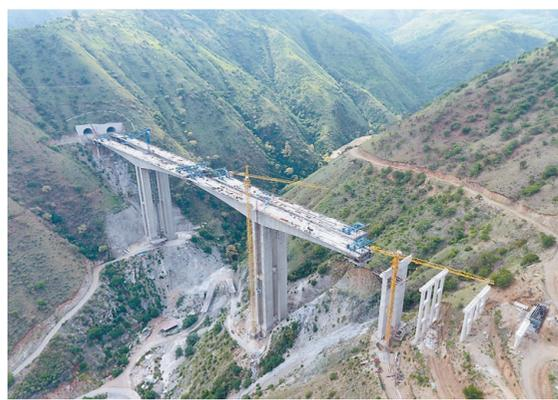
本报讯(记者 杨扬) 10月13日,元江至蔓耗高速(红河段)罕龙2号特大桥右幅边跨合龙段顺利浇筑完成,为元蔓高速(红河段)早日实现全省域高速“能通全通”工程目标迈出了坚实一步,这也是继罕龙1号特大桥边跨合龙后,元蔓高速(红河段)第二座实现边跨合龙的连续刚构特大桥。
