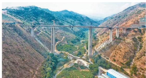
本报讯(记者 赵航)11月28日,元蔓高速(红河段)罕龙1号特大桥右幅4#、5#墩中跨合龙段顺利浇筑完成,标志着元蔓高速(红河段)首座连续刚构特大桥实现双幅架通,为元蔓高速项目确保实现全省域高速公路“能通全通”工程目标迈出了坚实的一步。
